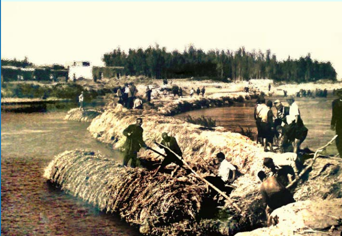
▲ بند انحرافی پوشالی زربینه رود: نمادی از خلاقیت، تلاش و کار گروهی در فرهنگ ایرانی (تاریخ عکس برداری: ۱۳۴۴/۳/۲۱)
